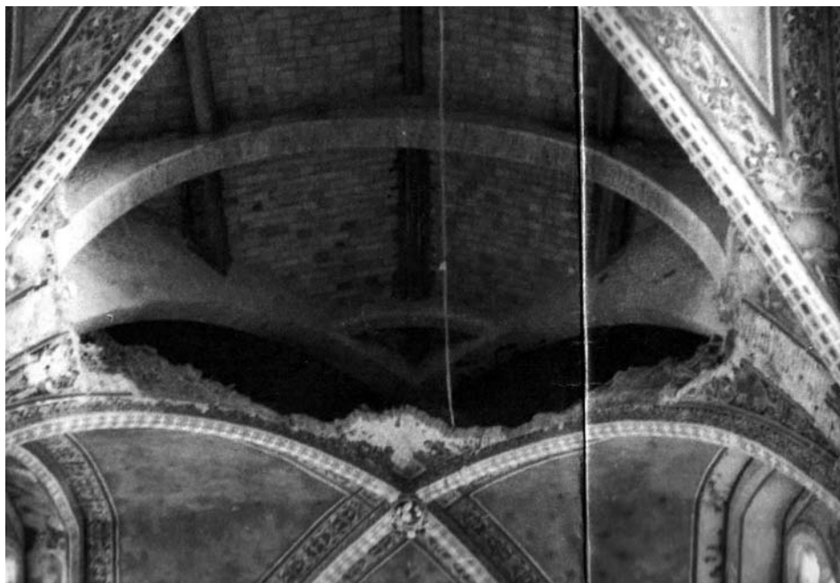
Fig. 9. Aspecto de una de las bóvedas tras la catástrofe (1997).
