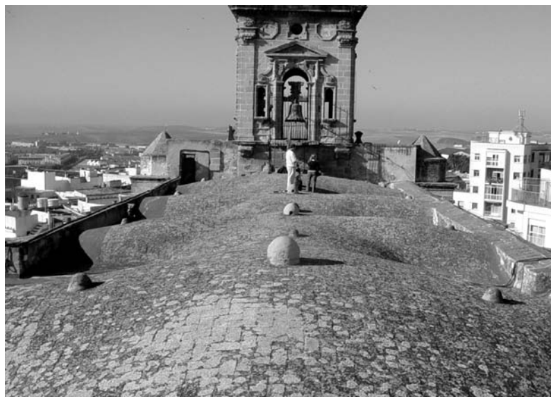
Fig. 17. Cubierta sobre bóvedas altas.
